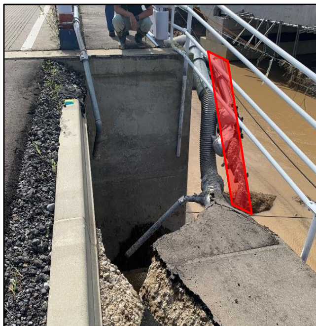
下水道管きょ損傷状況 (若山処理区広栗橋)
