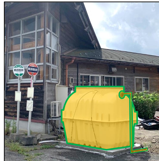
仮設浄化槽の設置 (宝立処理区鵜飼地区)
